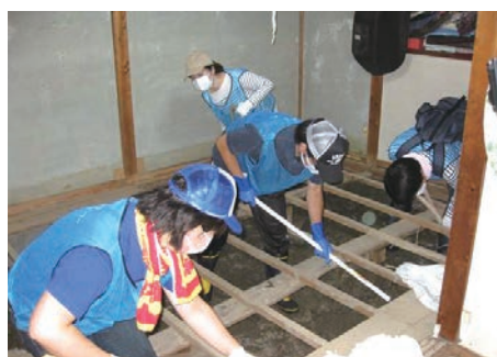
豪雨災害被災者宅の泥出し活動②
